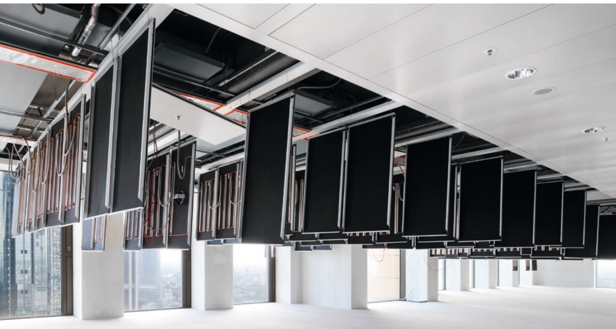
Neubau Opernturm, D-60325 Frankfurt am Main
